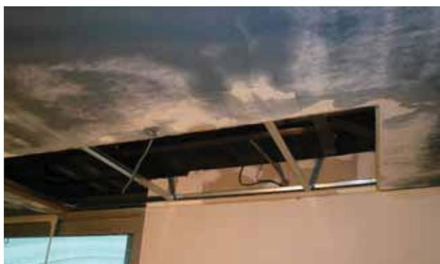
1. Démontage de la zone touchée et ponçage des abords
