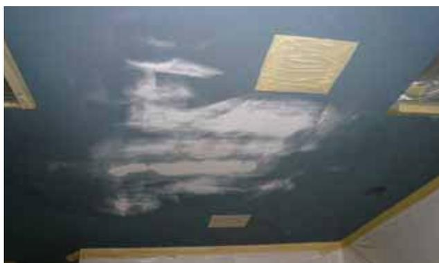
3. Ponçage des joints secs et projection de la zone.
