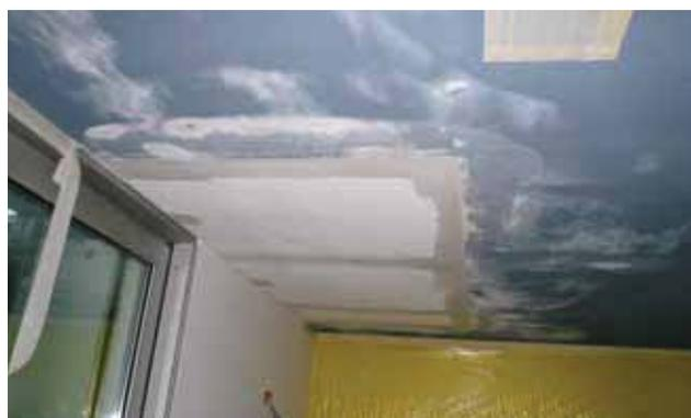
2. Pose des nouveaux panneaux et enduisage des joints
